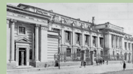
Budova dnešnej Centrálnej banky Ruska začiatkom 20. storočia
